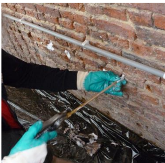
Fig. 6. Impregnering met een crème.
