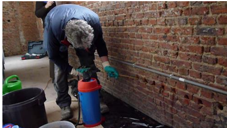
Fig. 4. Impregnering zonder druk.
