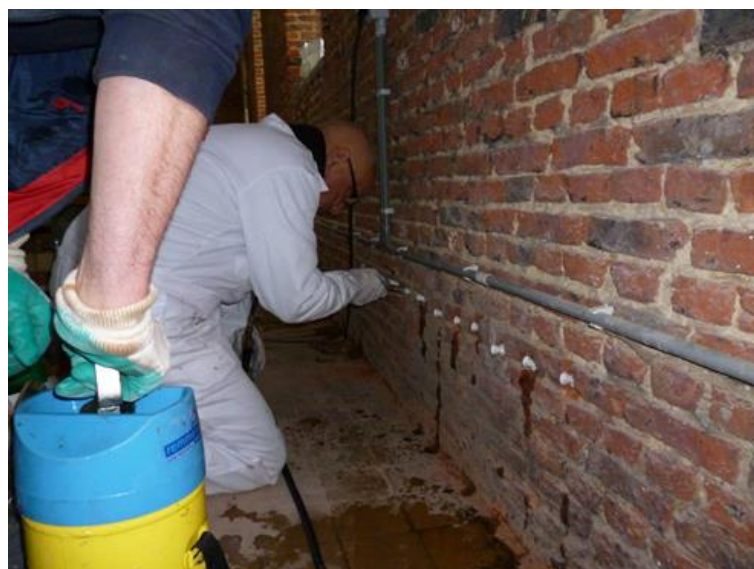
Fig. 5. Injectie met druk.
